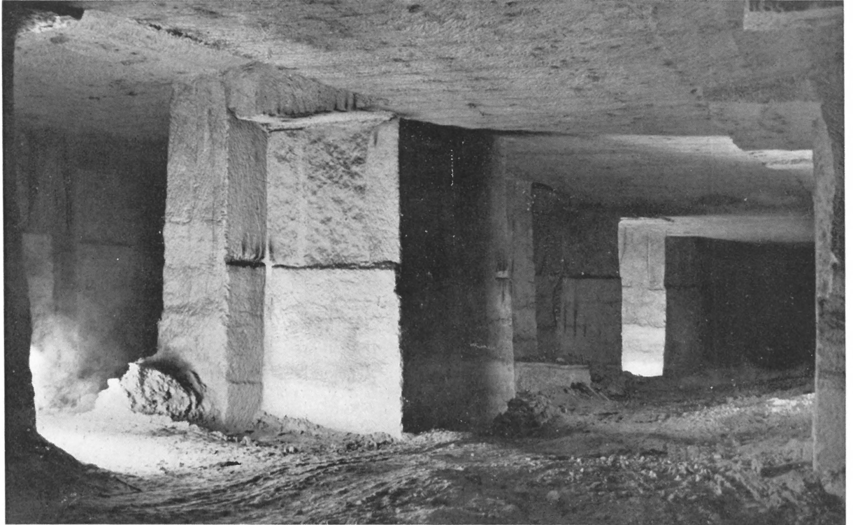
Ausschnitt aus dem Pfeilerbau des Römerbruches in Aflenz bei Leibnitz.
